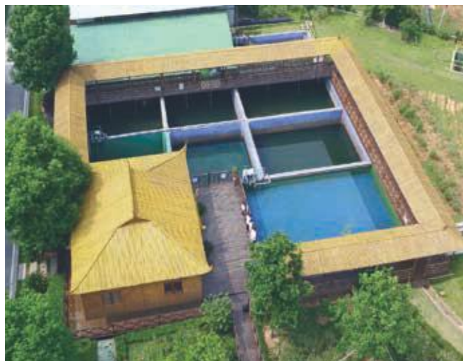
* 圖為天能綠色循環經濟產業園 Circular Industrial Park
