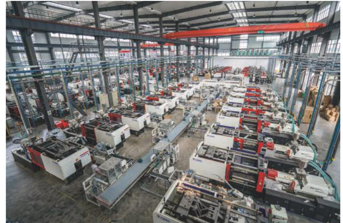
* 圖為智能製造產業園 Intelligent Manufacturing Industrial Park
